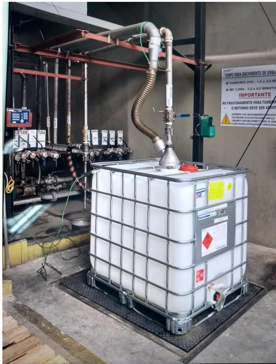
Detalhe do fio que interliga o dispositivo metálico existente na parte interna da válvula de saída de líquido do IBC, ligado à grade metálica.
